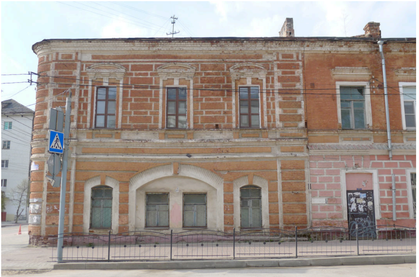
Фото 4. Левый фланг северного фасада.
