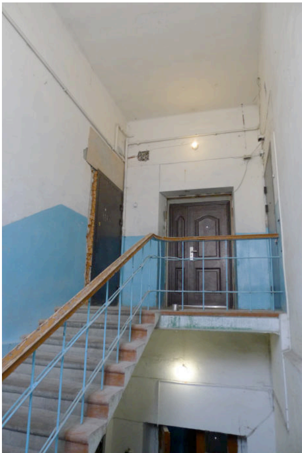
Фото 14. Лестничная клетка в восточной части здания.
