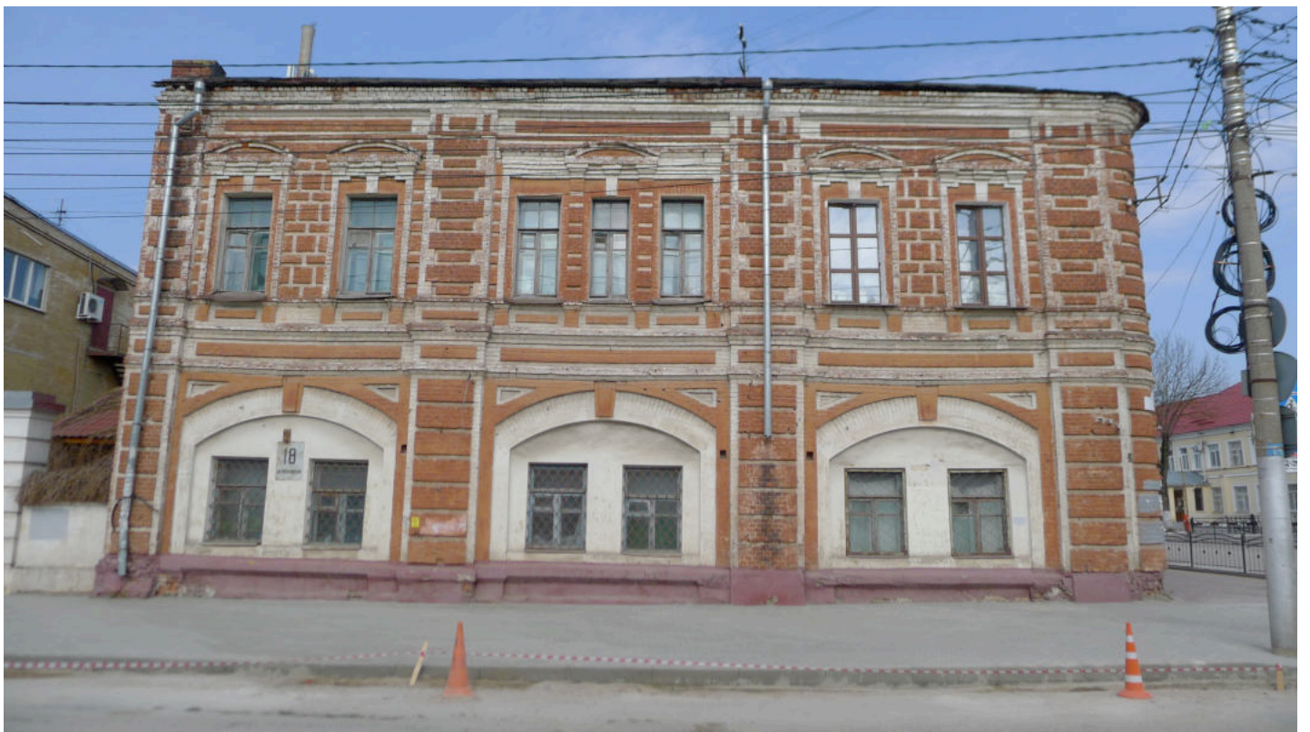
Фото 6. Восточный фасад восточного крыла.
