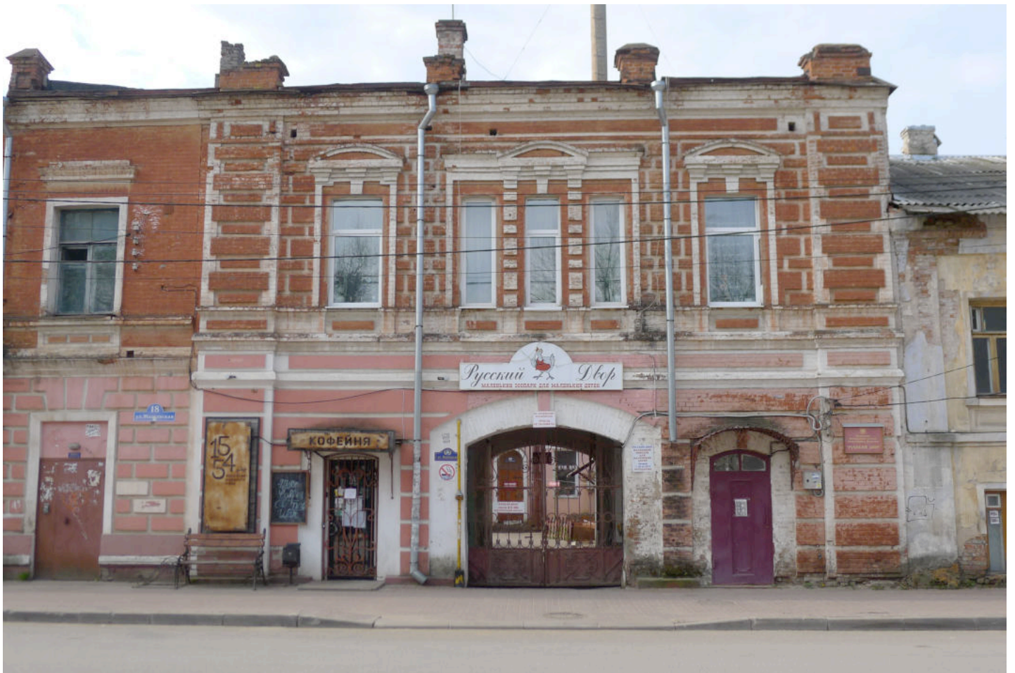
Фото 5. Правый фланг северного фасада.
